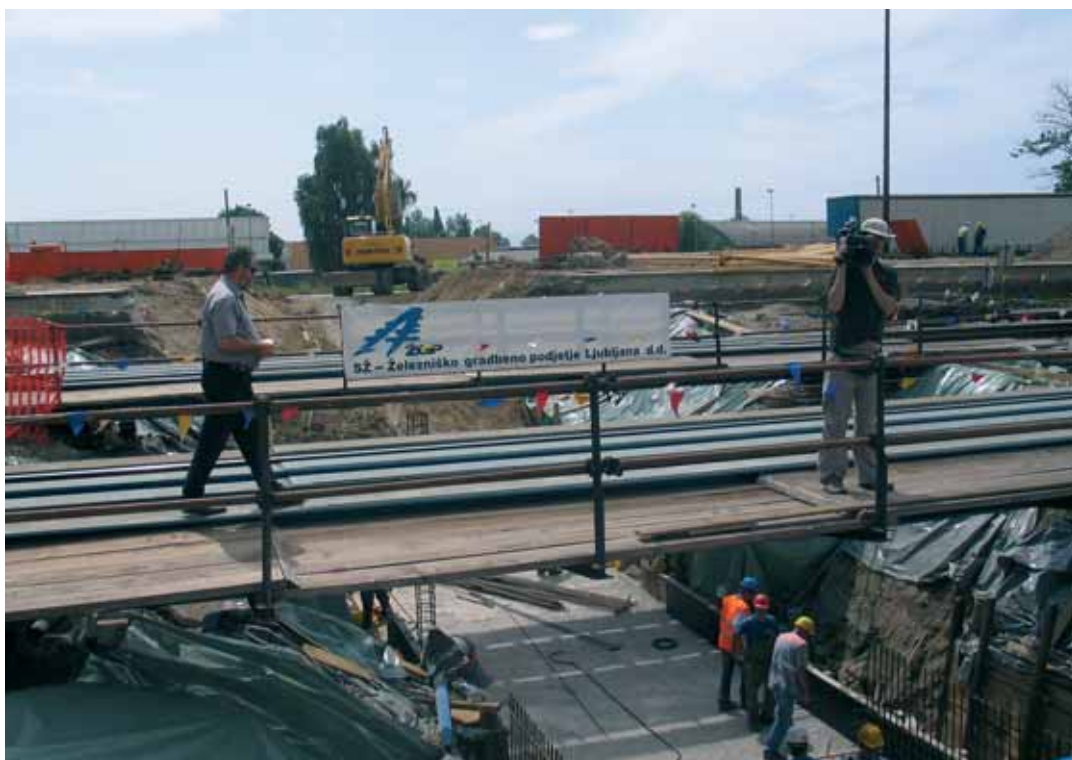
Gradnja podhoda na postaji Ptuj.
