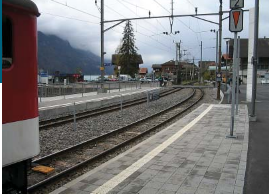
Železniška postaja Brienz (565 m n.m.v.), opremljena z ETCS.
